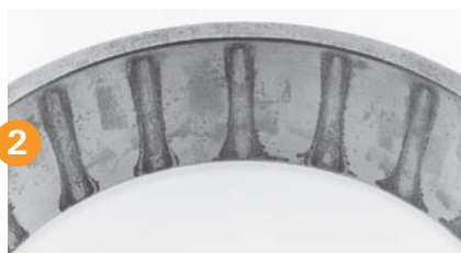
Manchas Manchas superficiais, sem corrosão significativa associada a umidade.
